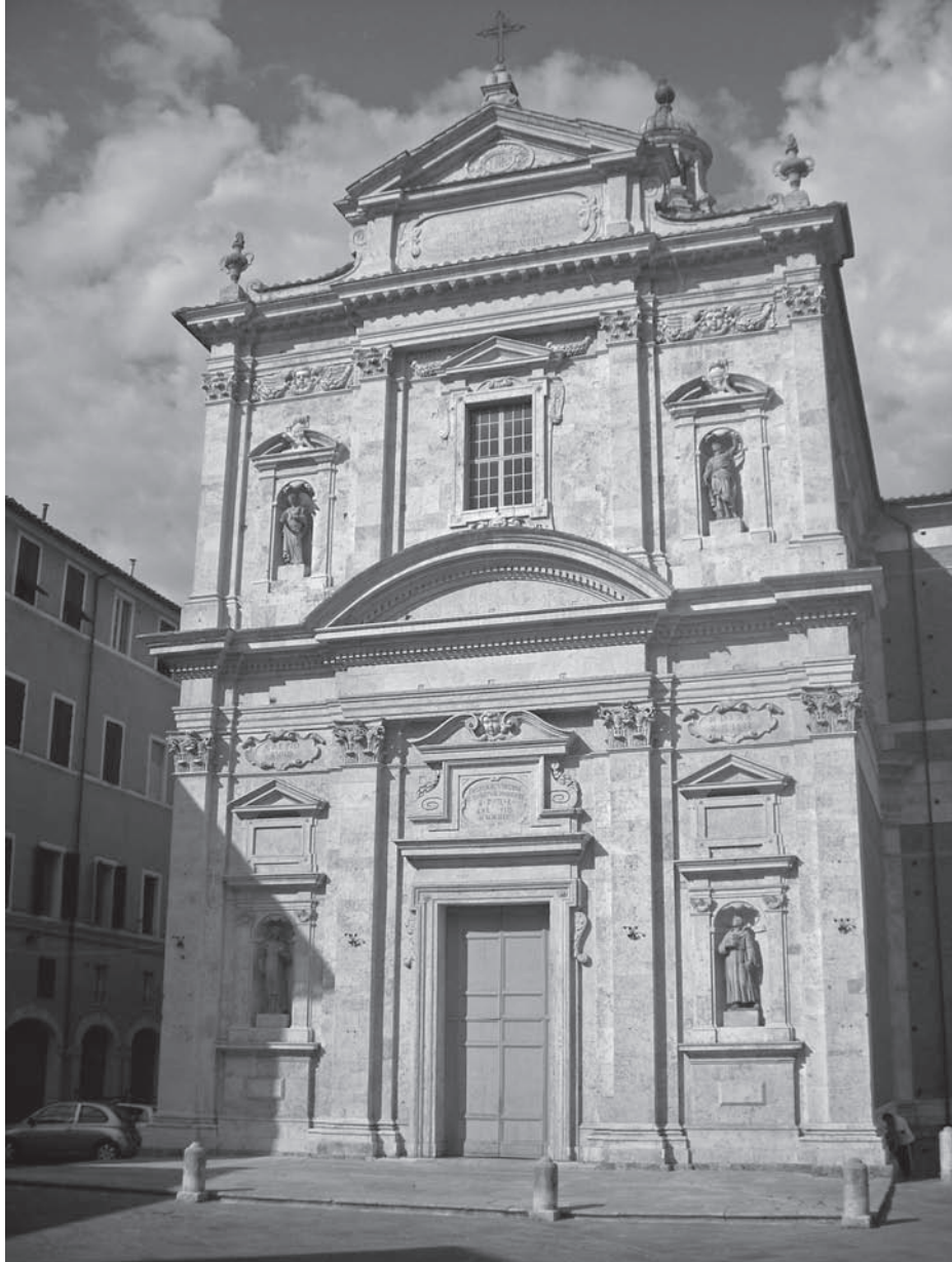
1. Siena, Facciata della basilica di Santa Maria in Provenzano.
